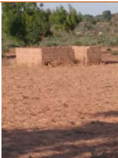
Les fondations sur le site
