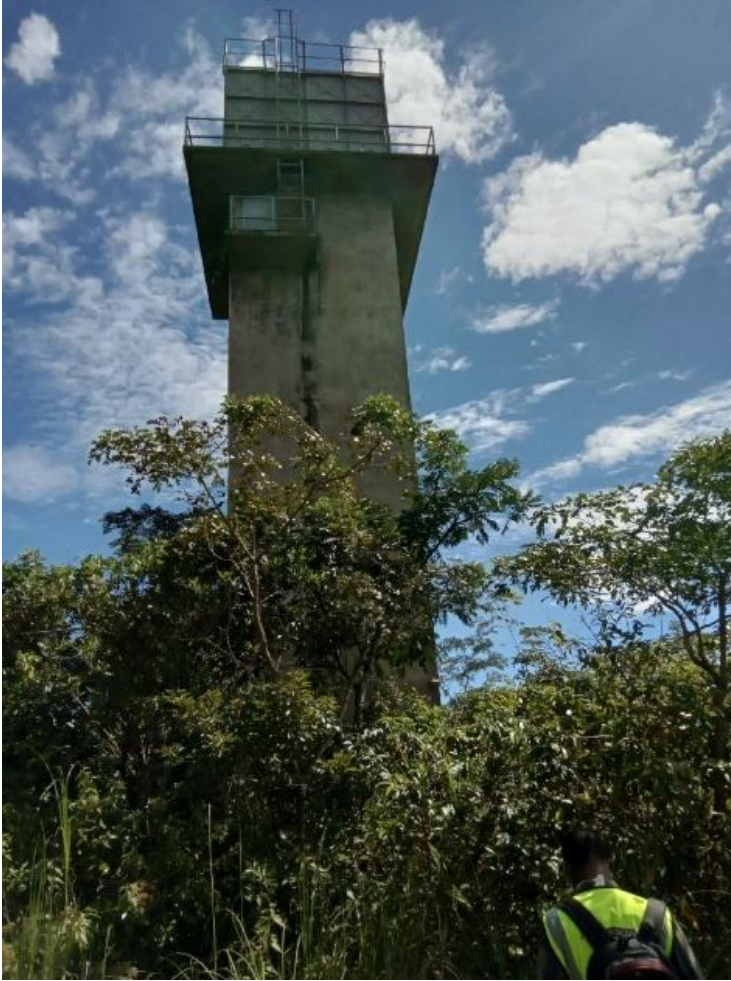
Photo 31; Château de distribution d'eau communal
