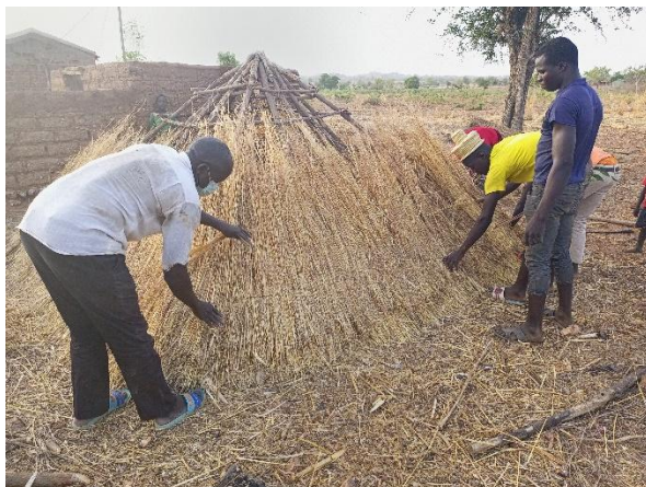
Photo 2 : Construction d'un toit en paille
