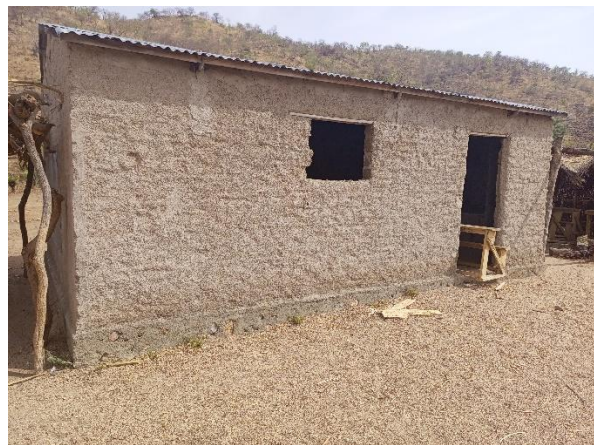
Photo 1 : Maison en sémi-dur (terre battue recouverte de béton)
