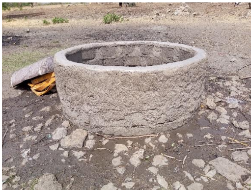
Photo 15 : Un puit busé situé dans l'emprise du projet au carrefour Paha
