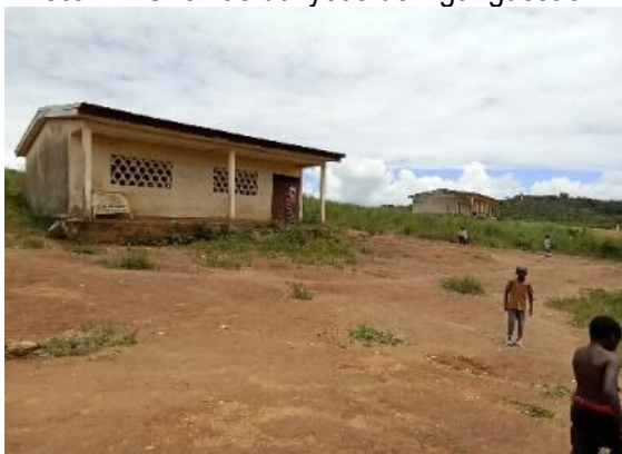
Photo 23: Une vue de l'école publique de Garbaya Yelwa.
